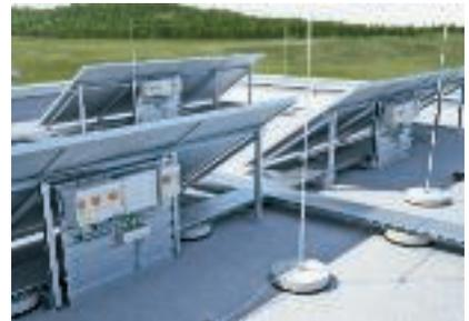
*izolovana gromobranska zaštita i kombinovani odvodnik na inverteru*
