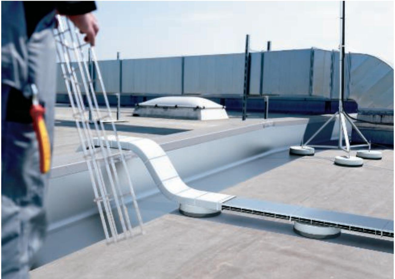
*Zaštićeno premošćavanje protivpožarnog zida pomoću zaštitnih vatrootpornih obloga*
