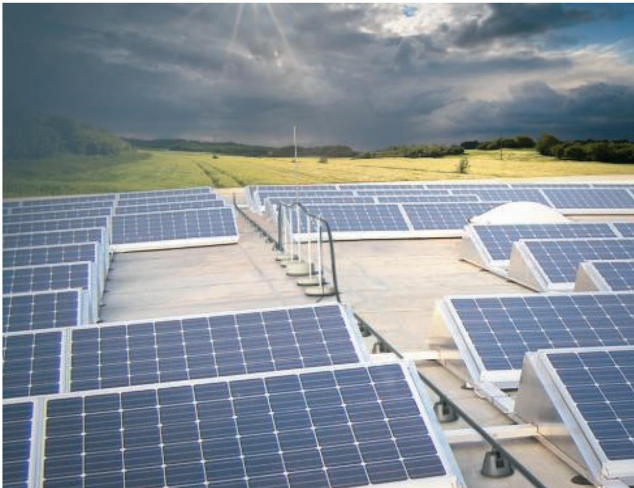
Ravan krov sa fotovoltaič-sistemom i izolovanim isCon®-provodnikom
