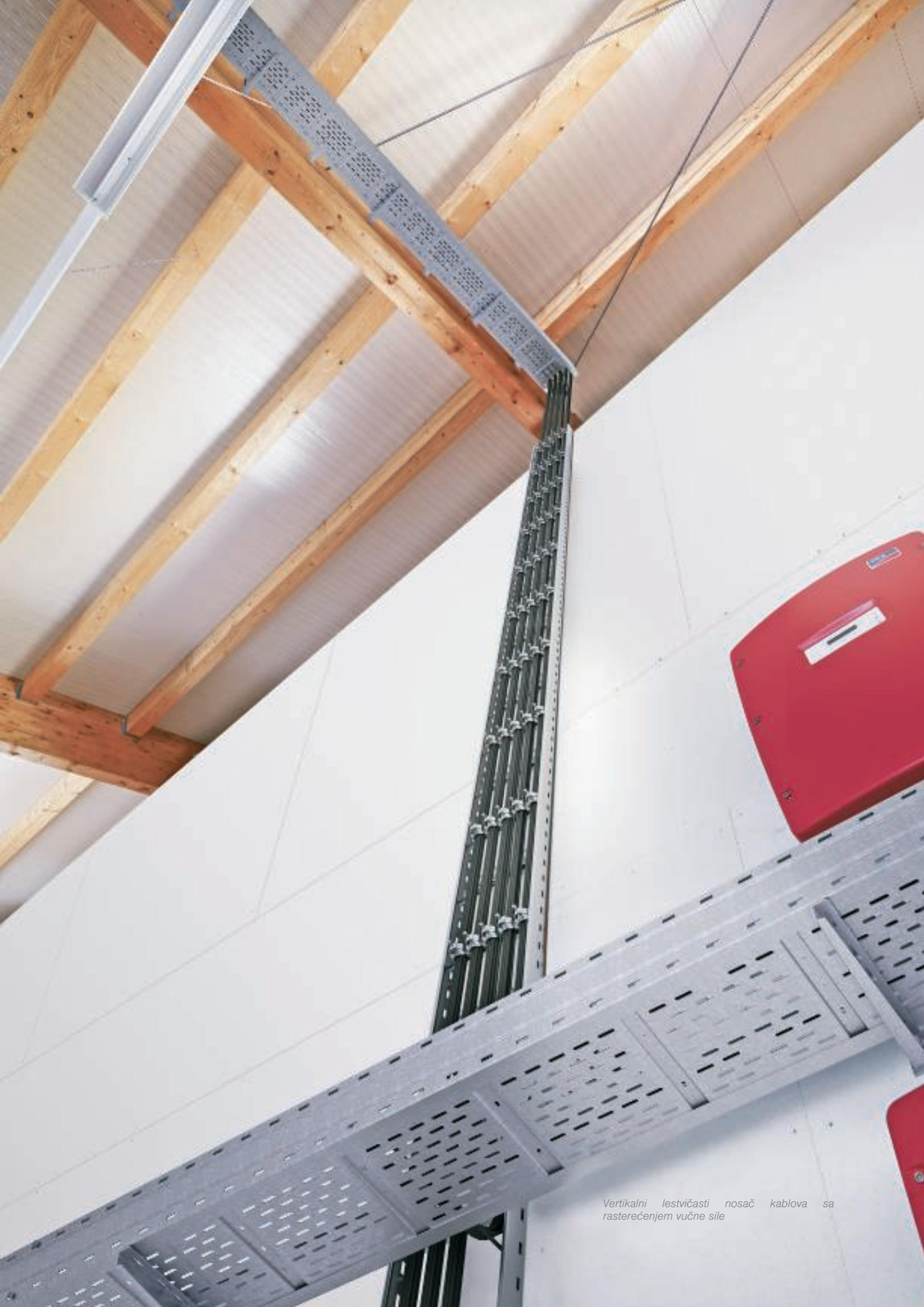
*Vertikalni lestvičasti nosač kablova sa rasterećenjem vučne sile*
