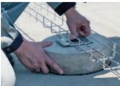
TrayFix montažni adapter i fiksnu ploču postaviti, čvrsto pritisnuti, gotovo
