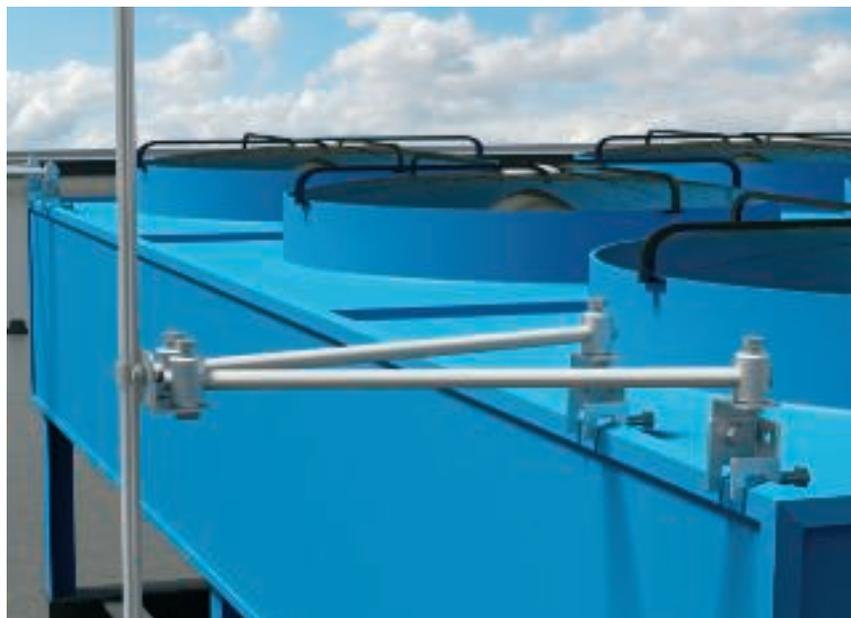
izolovana gromobranska zaštita sa GfK-držačem na agregatu za hlađenje
