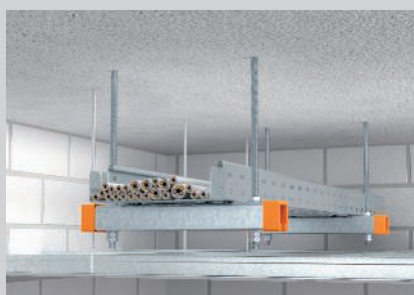
Plafonska montaža iznad visećeg protivpožarnog plafona na jednom nivou.
