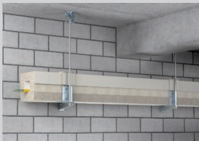
Zidna montaža na konzole i dodano osiguranje navojnim šipkama.
