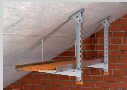
Montaža ispod kosih plafona s varijabilnom čeonom pločom.
