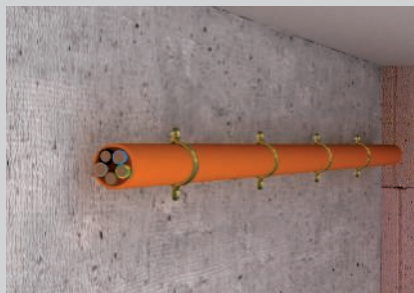
Vodoravna montaža kablova na zid.
