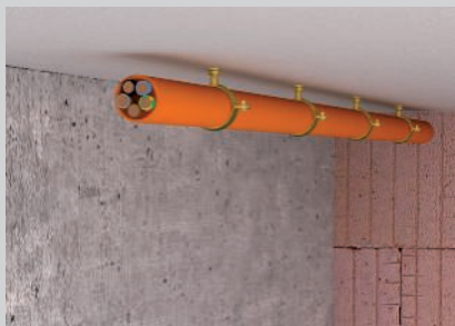
Montaža ispod plafona.
