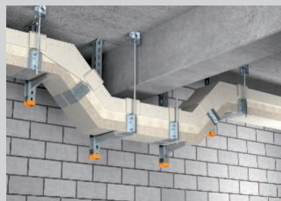
Pripremljeni fazonski komadi za promene pravca kod viseće montaže.
