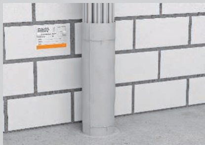
Zatvoriti malterom ostale otvore prodora i montirati pločicu za označavanje.
