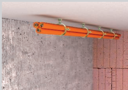
Instalacija snopova kablova ispod plafona.
