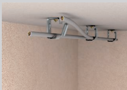
Otvaranje sabirnog držača i stavljanje kablova.
