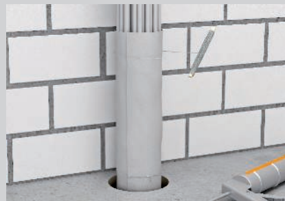
Fiksiranje bandaže pomoću namotane žice.
