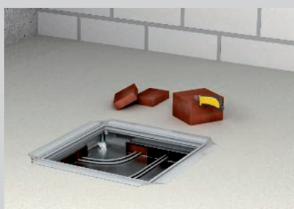
Iseći uzane trake za kanale.
