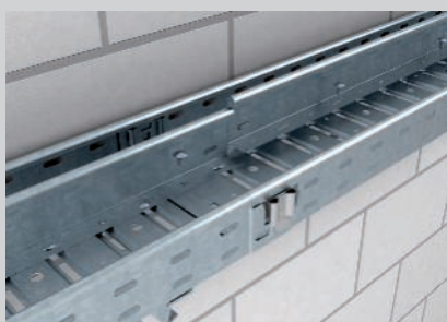
Montaža pregrada sa torban vijcima.
