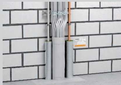
Instalacija protivpožarnih bandaža sa nultim rastojanjem u odnosu na Rockwool Conlit cevne prodore.
