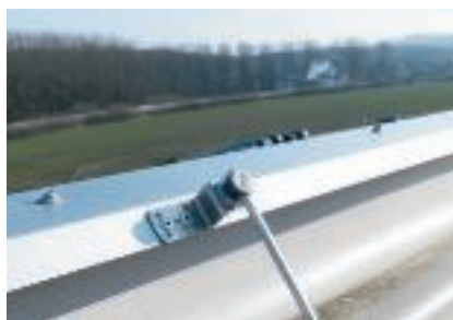
Parapetni zid povezan sa gromobranskim sistemom
