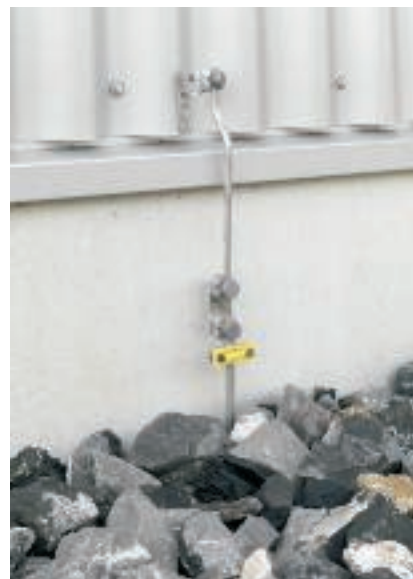
Razdvajajuća tačka u sistemu uzemljenja
